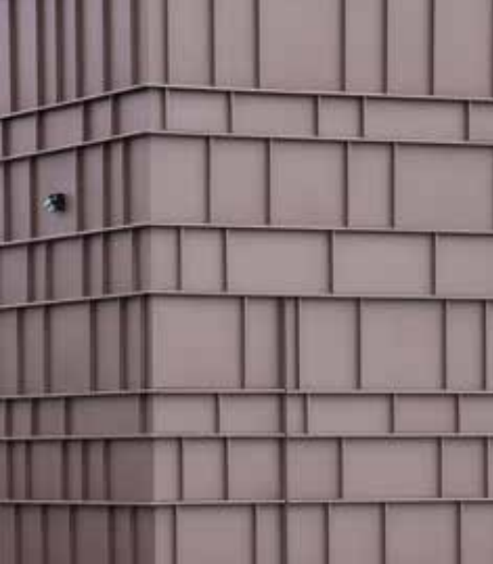
Düsey, yatay ve şaşırtmalı kenetler
