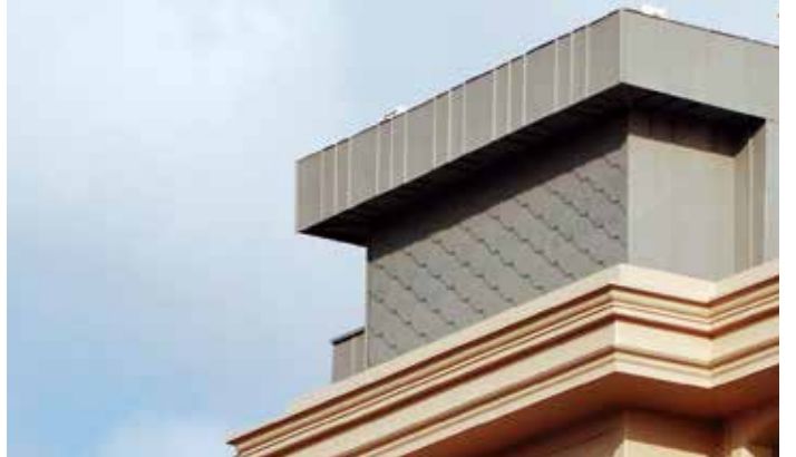
İncirli Paşa Apartmanı Bakırköy, İstanbul
